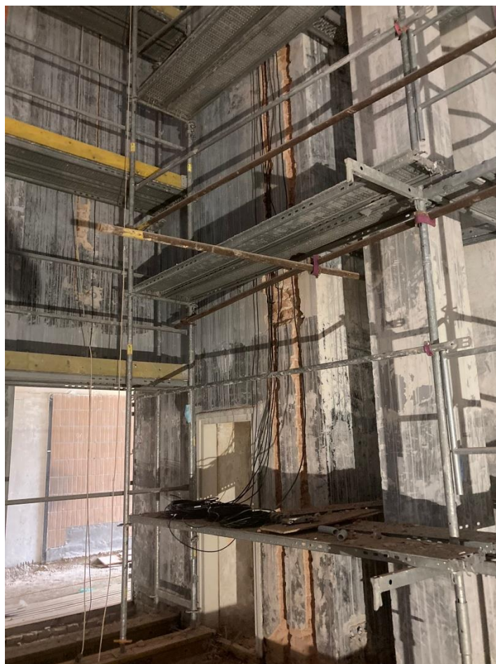
Obr. 5 – rekonstrukce velké obřadní síně na ÚH
