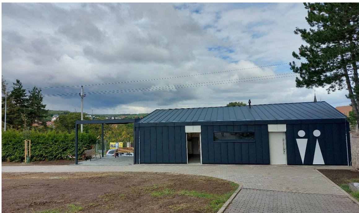
Obr. 3 – veřejné WC v Brně-Žebětíně
