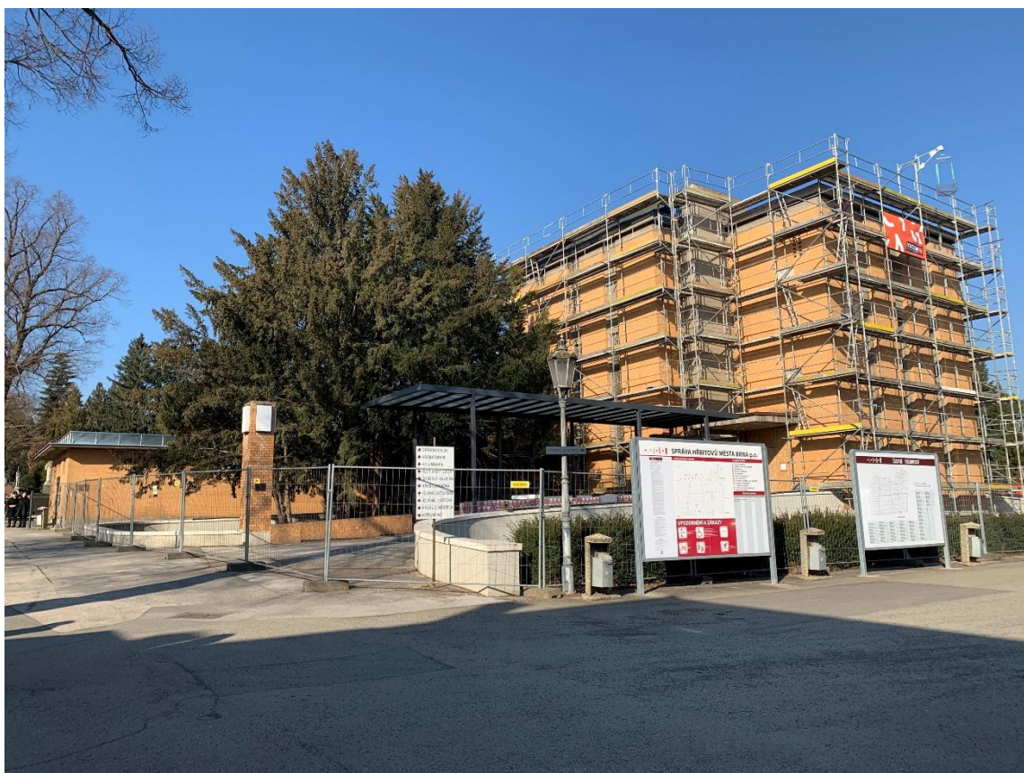
Obr. 4 – rekonstrukce velké obřadní síně na ÚH
